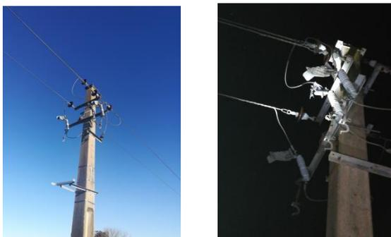
Analizando las causas, se determinó que no se realizaron las verificaciones visuales, no se aseguraron las instalaciones ni se colocó equipo de puesta a tierra en el lugar del accidente. Asimismo, se vio que el seccionador bajo carga era difícil de visualizar y que el liderazgo fue inadecuado.
